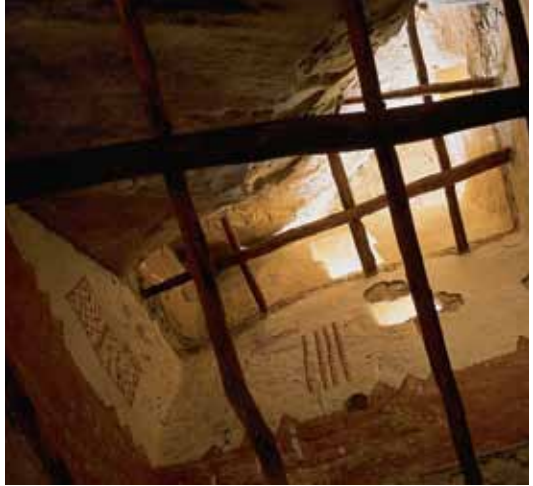
Les poutres d'origine et le plâtre peint sont encore visibles dans la structure de quatre étages à l'extrémité sud du Cliff Palace.
